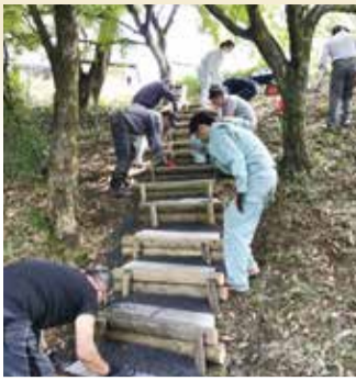
緑が丘団地もみじ谷整備
