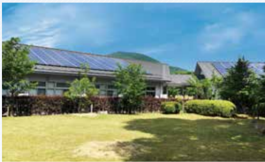
▲フリーソーラーを設置した「湯布院福祉センター」
