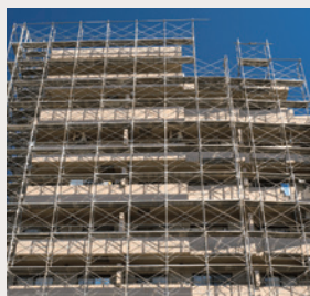
外壁の塗り替えは4～6年に1回、外壁の補修・屋上の防水補修は12年に1回が目安とされています。
