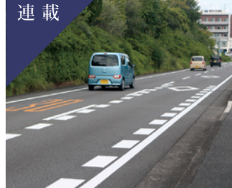
明野団地内の時速30km規制エリアの幹線道路。交通量が多いが、車の流れは良い。
