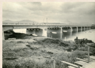
↑西日本水害によって流出した大分川に架かる舞鶴橋、再建工事完了の様子。木製から鉄筋コンクリート製に変更した。
