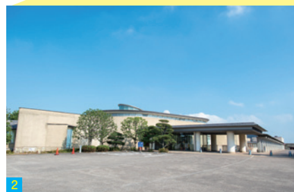
1.安藤忠雄氏によるゾウの彫刻「遊星散歩」が設置された展望広場。幅広い世代に親しまれる人気のスポットだ
