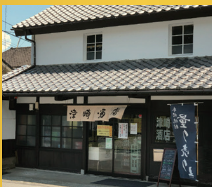
酒蔵の名残があるショップの外観。熊本地震により被害を受けた建屋を改装した。
